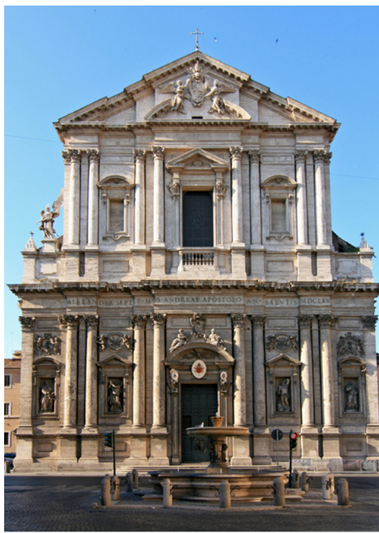
Barokní průčelí kostela Sant'Andrea della Valle
